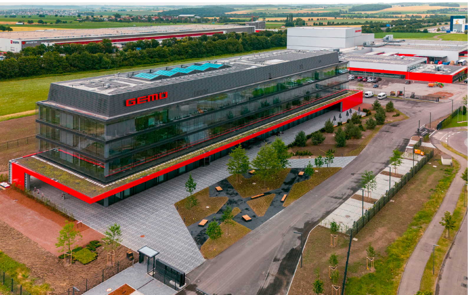
GEMÜ Headquarter im Gewerbepark Hohenlohe Foto: GEMÜ Gebrüder Müller Apparatebau GmbH & Co. KG
